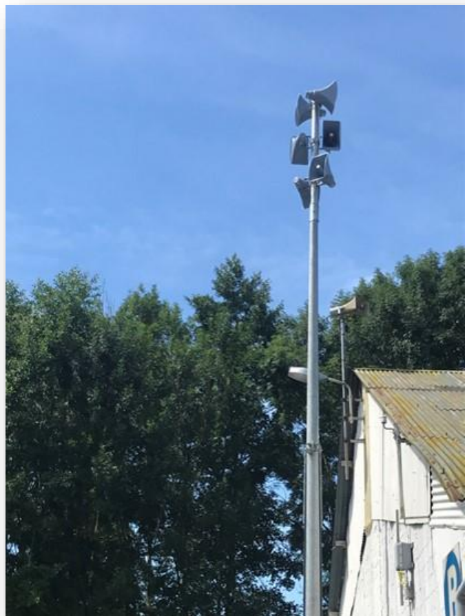
Nouvelle sirène PPI avec une portée à 500m
