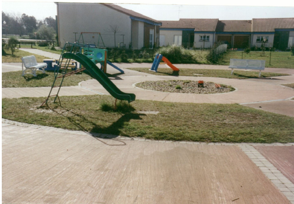
Terrain de jeux permettant le stockage des eaux (photo GRAIE)
