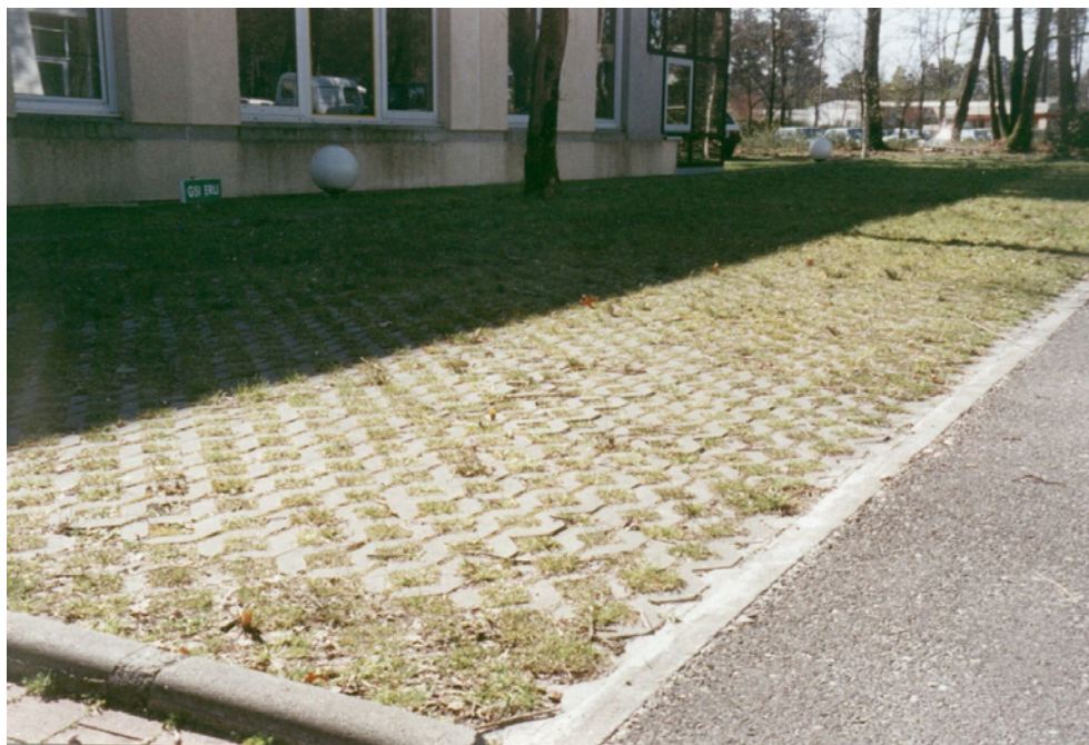
Revêtement perméable dans la région de Bordeaux (photo JD Balades CETE SO)
