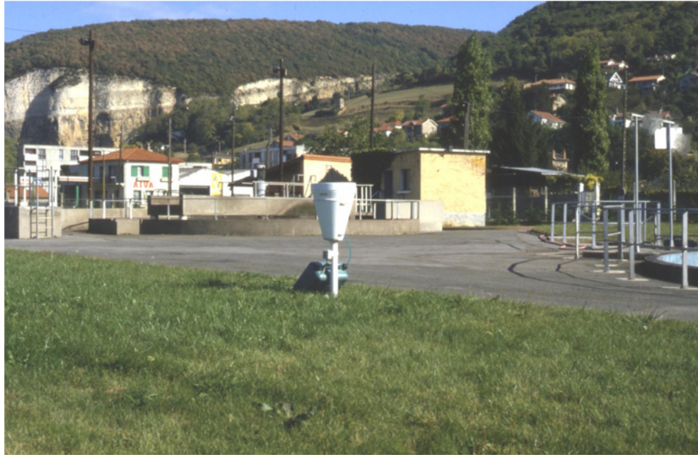
Pluviomètre enregistreur installé dans l'enceinte d'une station d'épuration (photo INSA Lyon)
