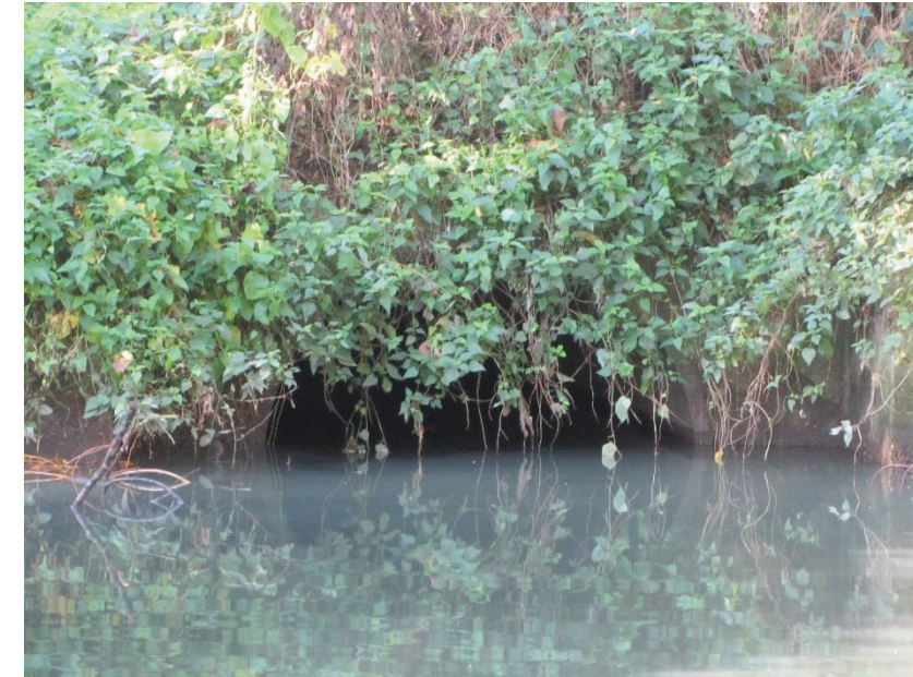
Figure 13 : Sortie aval de la section busée du ruisseau « le Rouillon »
