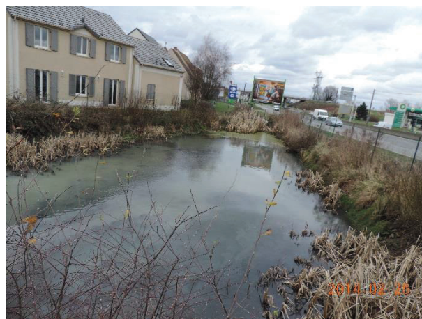
Bassin de rétention non bâché
