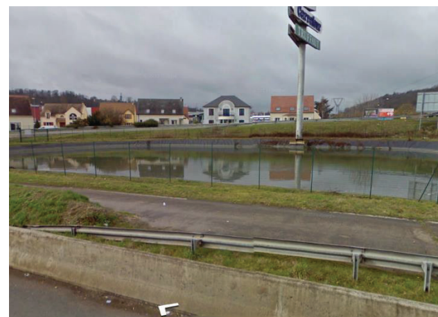
Bassin de rétention bâché (source : Google street view)
