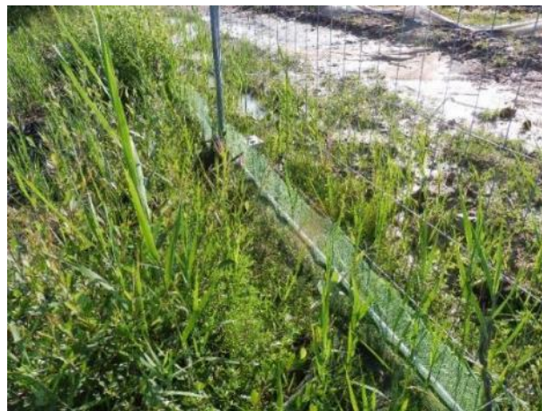
Photo 26: Barrière à amphibiens en doublement d'une barrière de chantier de type Heras
