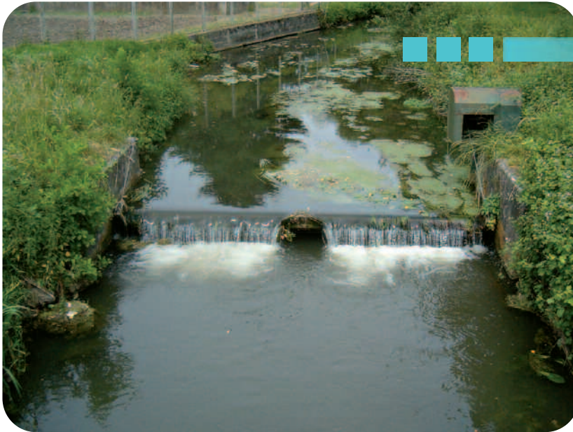
Prolifération d'une végétation aquatique liée aux eaux stagnantes sur une retenue du Couasnon (Maine et Loire)
