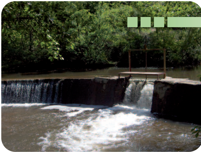
Seuil du Moulin Marin sur la Besbre – Allier
