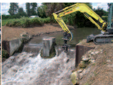
Seuil pendant travaux : retour à un écoulement libre 2008
