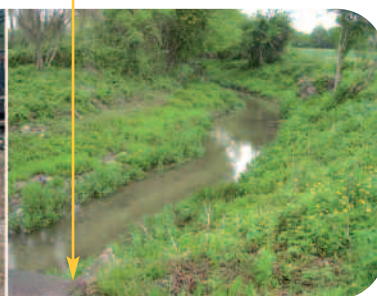
Après travaux : absence de problèmes d'eutrophisation 2009
