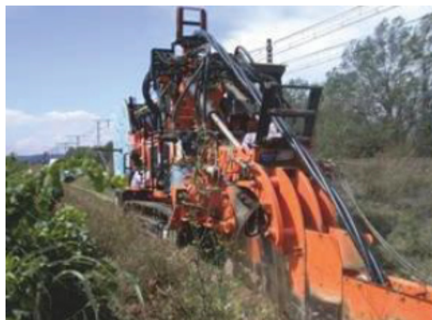
Figure 21 : Création d'un tranché de raccordement
