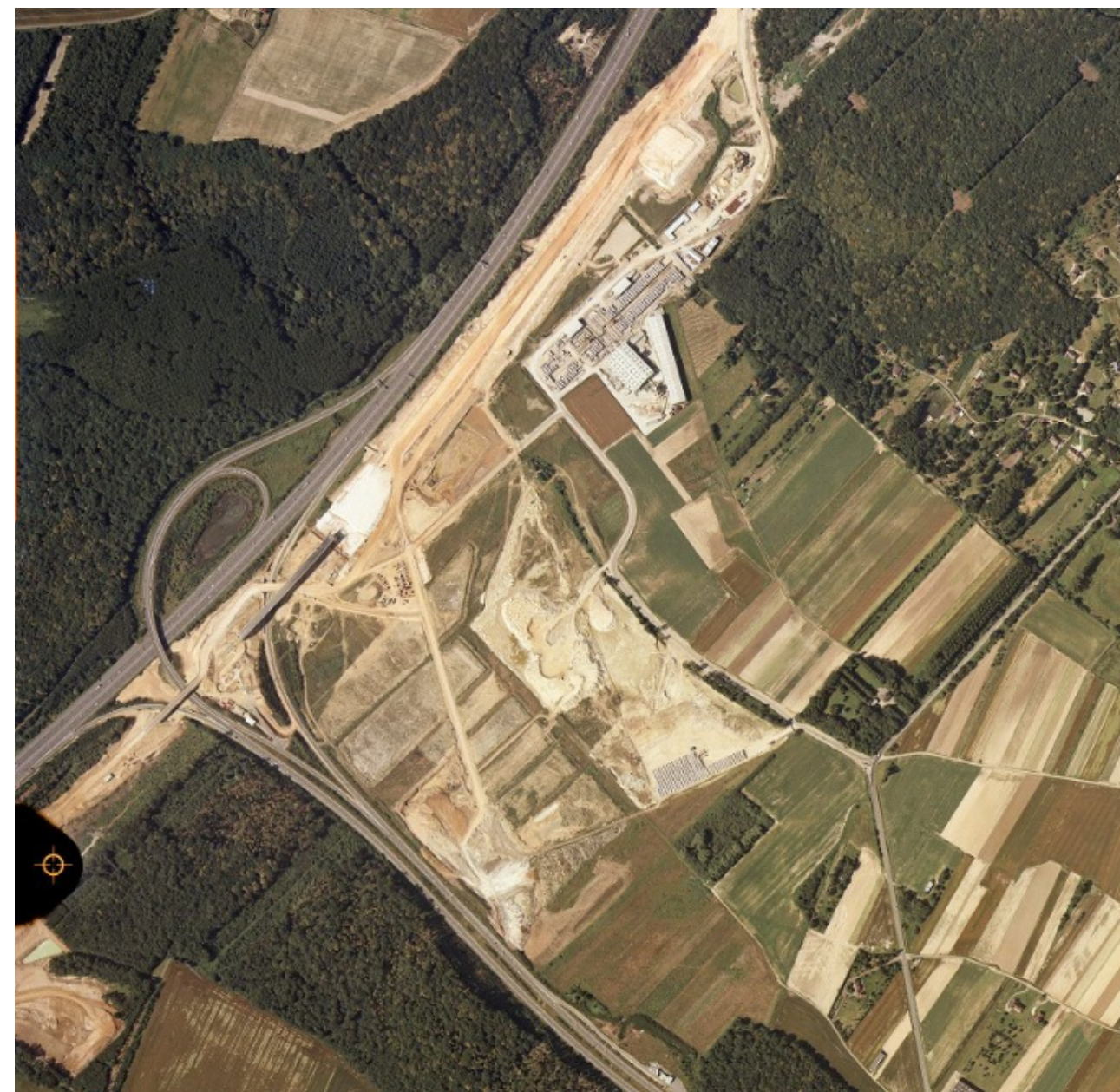
Figure 7 : La construction de ligne TGV atlantique en 1987
