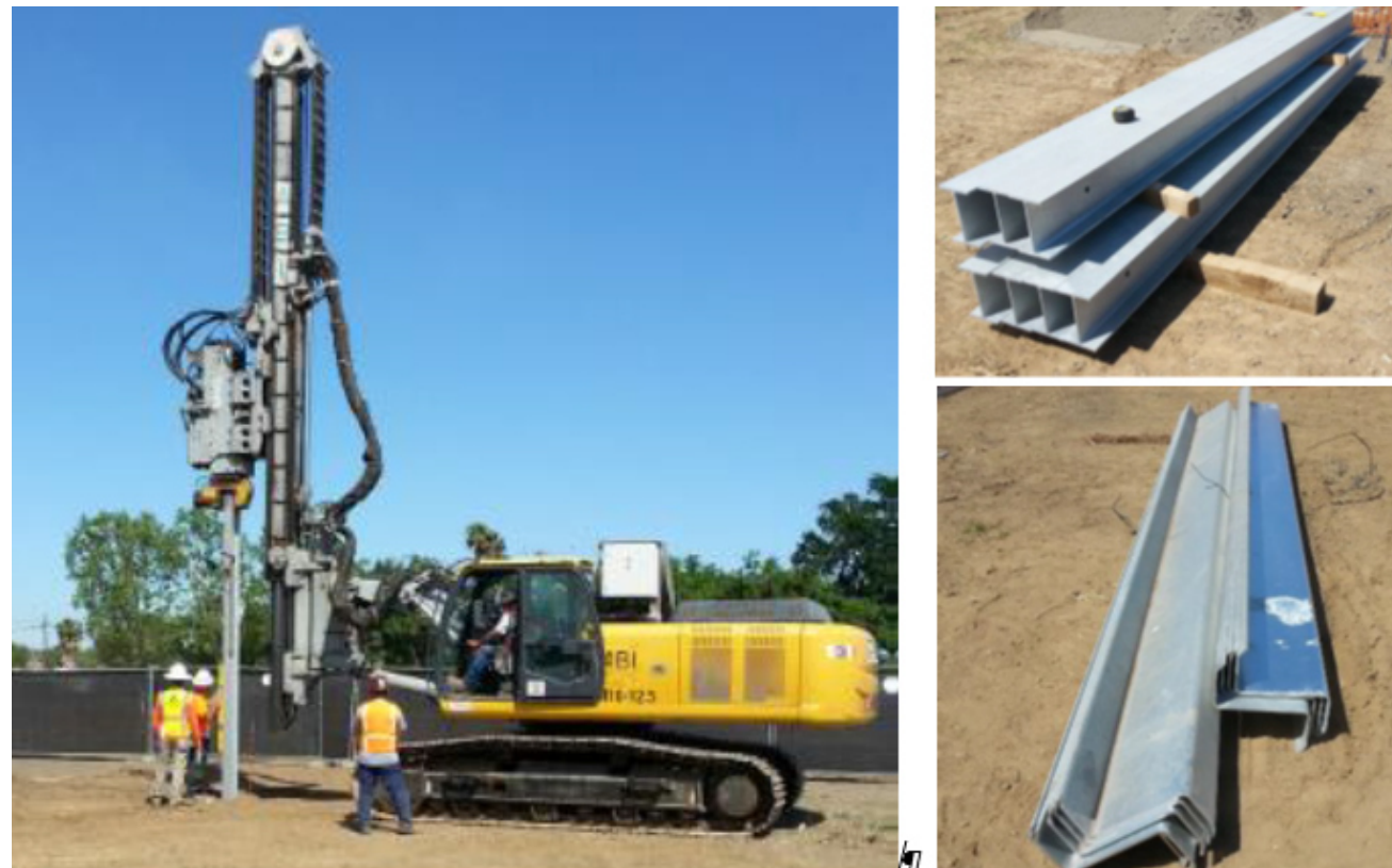
Figure 19 : Mise en place des pieux battus au sol
