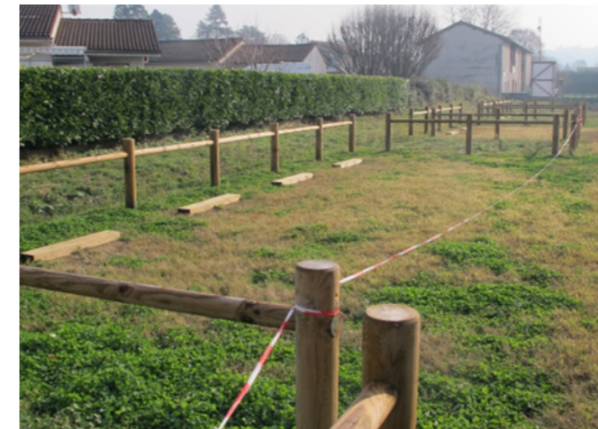
Figure 21 Illustration de places de stationnement constituées au moyen d'un mélange terre-pierres dans le cadre de l'aménagement des zones humides de la Sauzayes à Chaponnay (69) incluant la mise en œuvre d'équipements pour l'accueil du public (conception, suivi de chantier et clichés Biotec).
