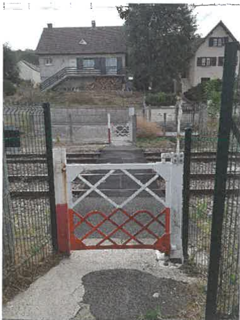
Photographie côté route de Corbeil (Voie 2)
