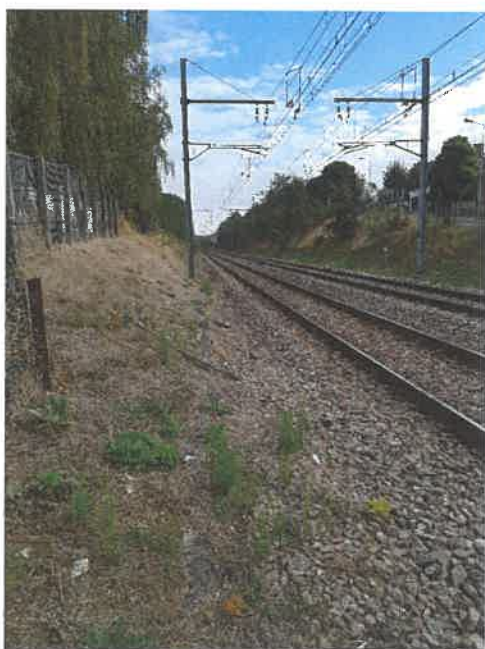
Visibilité à 1.50m de la voie 2 côté Nord
