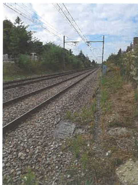
Visibilité à 1.50m de la voie 2 côté Sud
