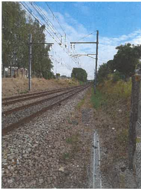
Visibilité à 1.50m de la voie 1 côté Nord
