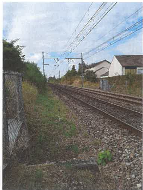
Visibilité à 1.50m de la voie 1 côté Sud
