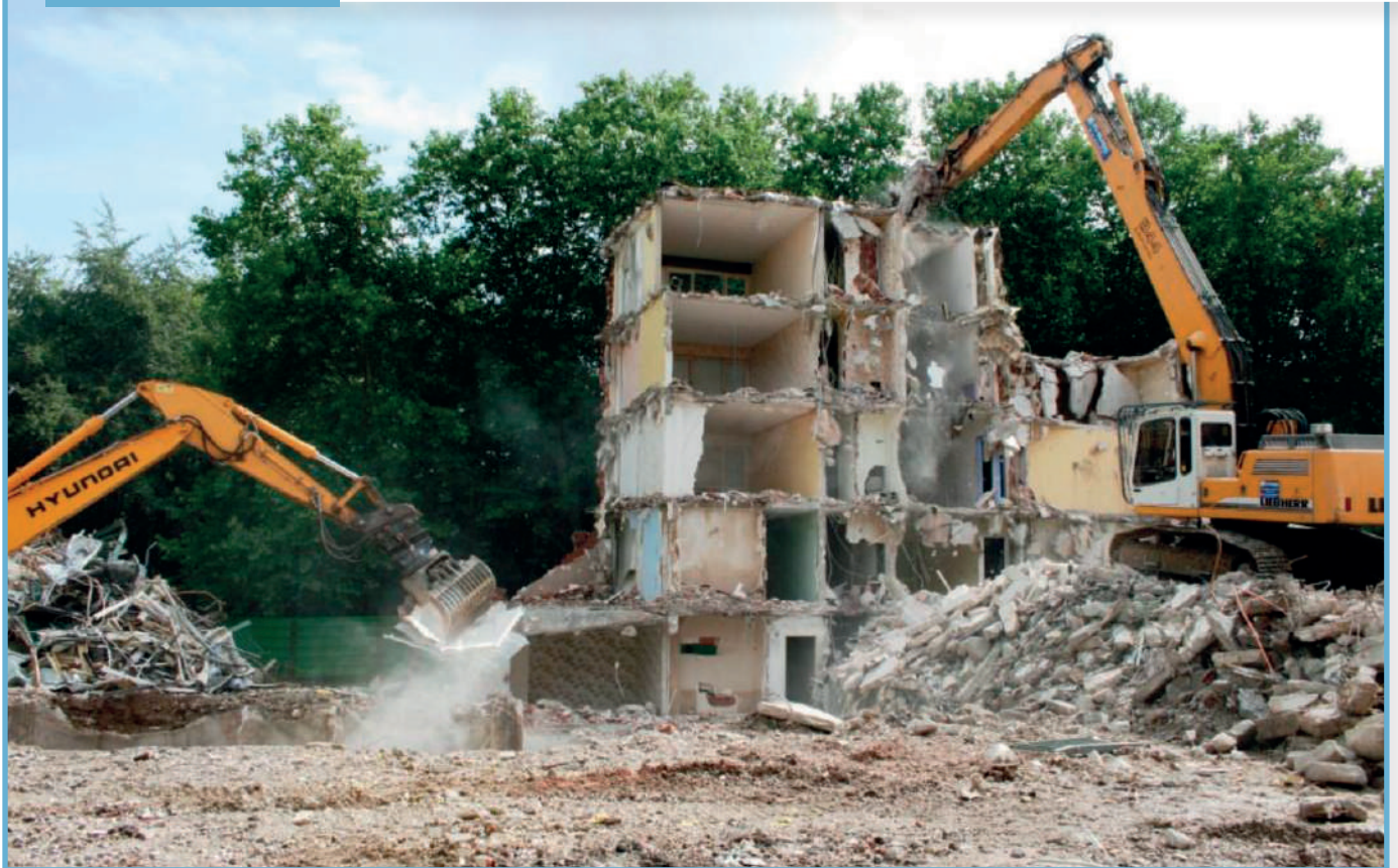
DÉMOLITION CINÉASTES Épinay-sous-Sénart
