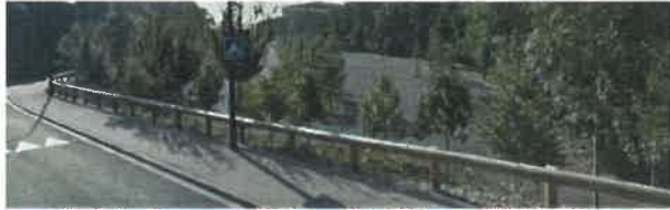
Figure 13 : Illustration de glissière mixtes bois-métal de sections rondes
