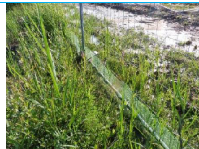
Figure 86 : barrière à amphibiens en doublement d'une barrière de mise en défens
