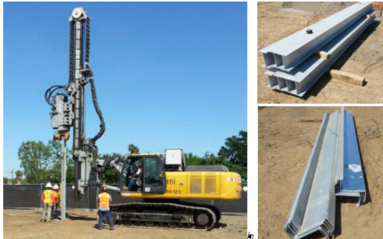
Figure 13 : Mise en place des pieux battus au sol
