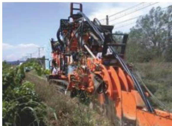
Figure 15 : Création d'un tranché de raccordement
