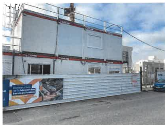
Construction en cours de la Maison des Services Publics rue Jules Vallès, côté Sud de la place Jules Vallès
