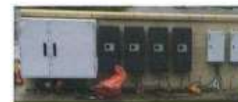
Le mur de sécurité (spécificité chaussée PV)
