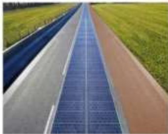
Chaussée solaire (RD5 - Tourouvre [61])
