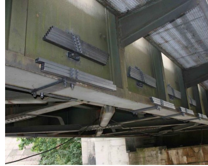
Illustration 13: Absorbeur sur platelage
