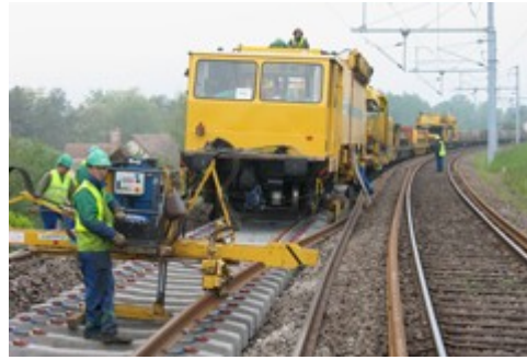
Illustration 9: Longs rails soudés sur travers béton
