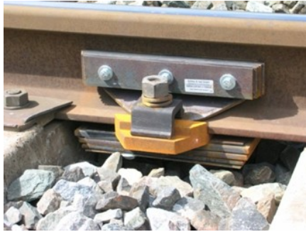
Illustration 12: Absorbeur sur rail
