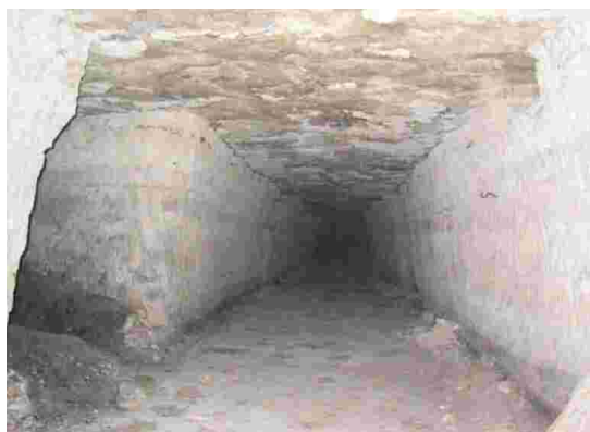
Fig. 13 - Galerie nord, 135 m de longueur.
