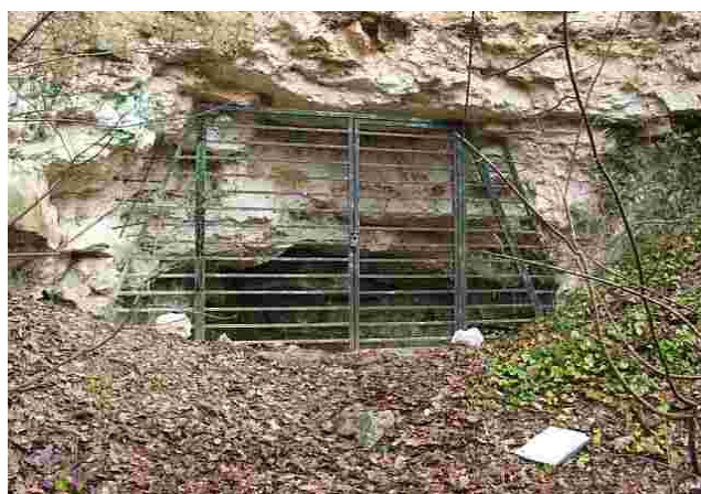
Fig. 23 - Grille de protection de l'entrée 1
