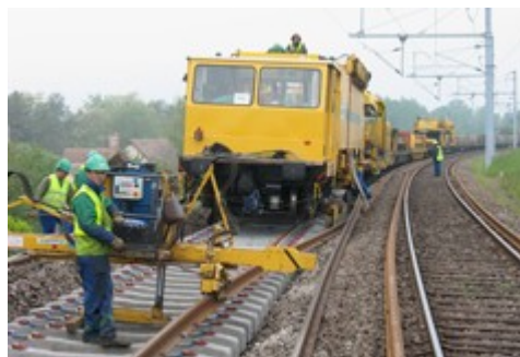
Illustration 9: Longs rails soudés sur travers béton
